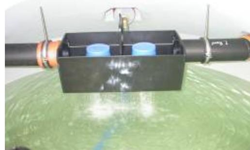
13. Dans la citerne : enfoncez le capuchon en plastique (pos. 1) avec les conduites d'installation montées (conduite d'aspiration et câble de l'interrupteur à flotteur) sur le manchon tubulaire de l'élément tubulaire prémonté dans le cône.
