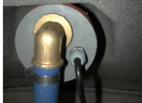
7. Dans la citerne : enfiler le câble de l'interrupteur à flotteur (pos. 5) par l'ouverture fileté préparée dans le capuchon en plastique fourni DN 100 (pos. 1). Pour cela, enroulez plusieurs fois le puisage flottant autour du tuyau d'aspiration (ou fixez-le avec des moyens de serrage).
